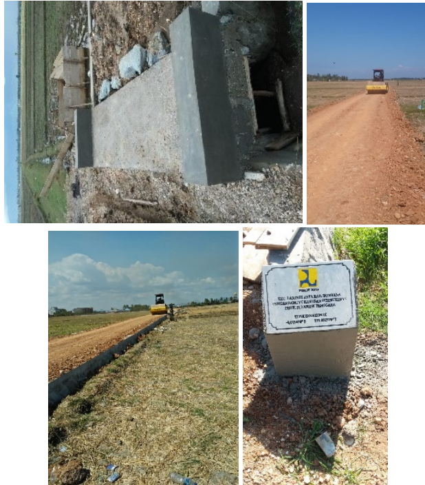
Gambar 6. Pemantauan dan Pengawasan Pelaksanaan Pembangunan Konstruksi
